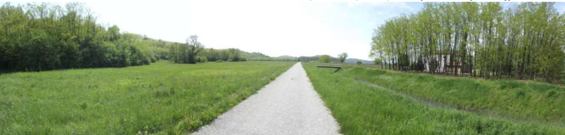
pista ciclabile su tracciato rurale preesistente. Sullo sfondo ponticello per l'attraversamento del torrente Versa
